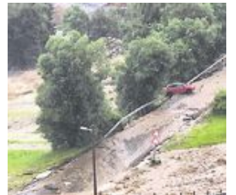
FLOM: Flom har ført til at begge veiene inn mot Utvik i Sogn og Fjordane ble ødelagt.
